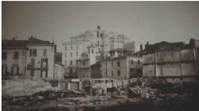
Demolizioni nello spazio destinato a ospitare l'attuale piazza Monte Grappa a Varese, 1930 circa (fonte: varesenoi.it)
